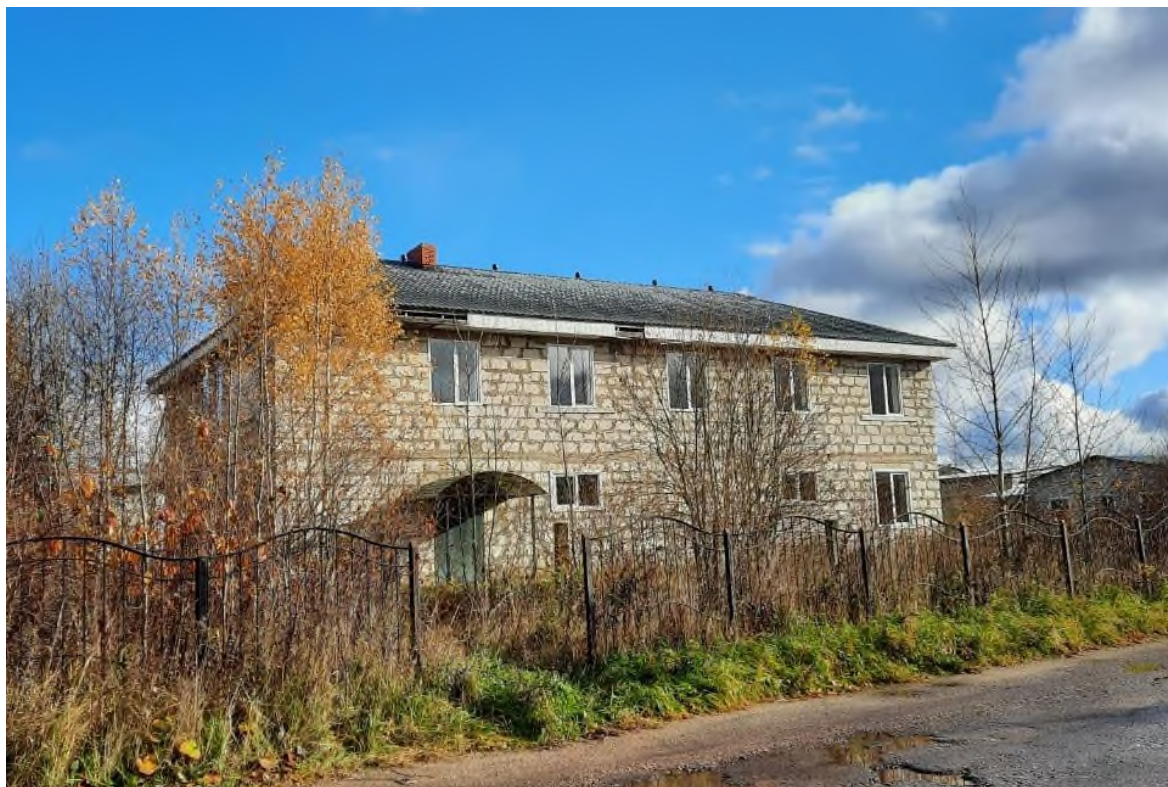
Офисно-производственное здание 2 этажа – 445,9 кв. м.
